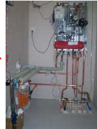
LVI ja kunnossapito: Kuntoarvion mittaus
