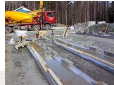
Uudisrakennukset: Betonivalujen kuivuuden valvonta
